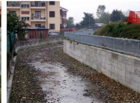
Il canale dopo l'intervento
