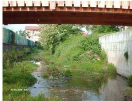
Il canale Prima dell'intervento
