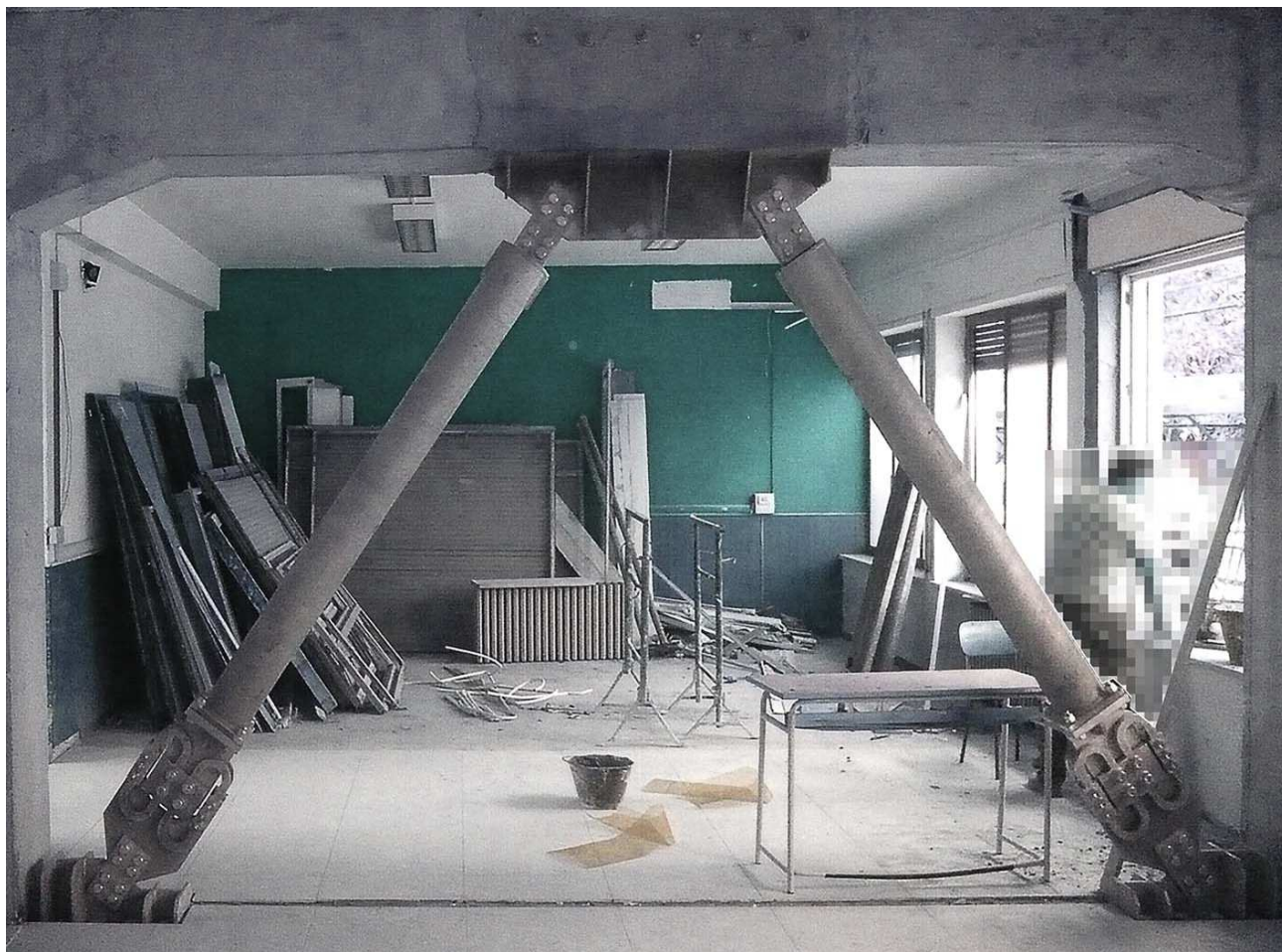
Installazione di controventi dissipativi
