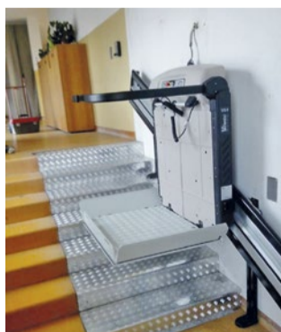
L'elevatore installato all'Enrico Fermi
