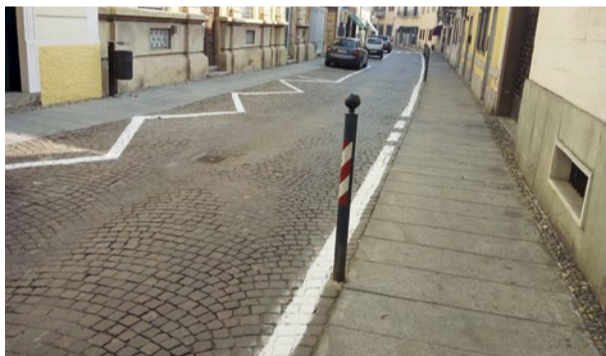
La nuova segnaletica orizzontale e verticale in via Marconi
