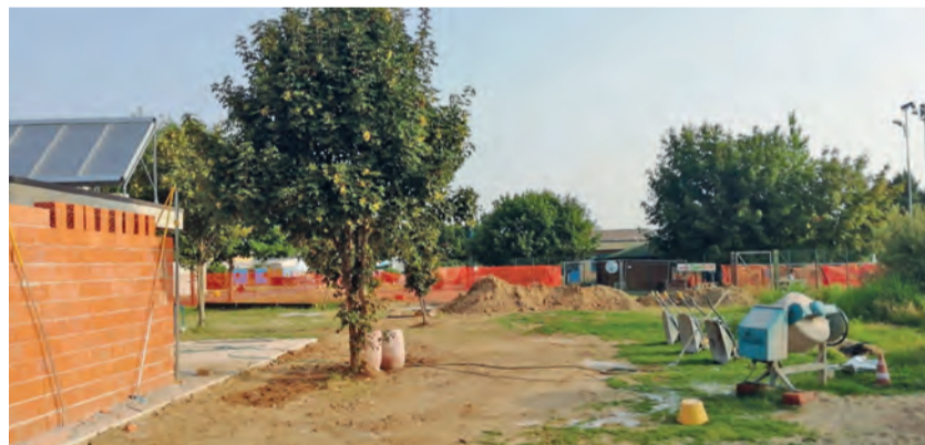
I lavori per l'installazione delle caldaie a pellet avanzano nel cantiere del Centro sportivo
