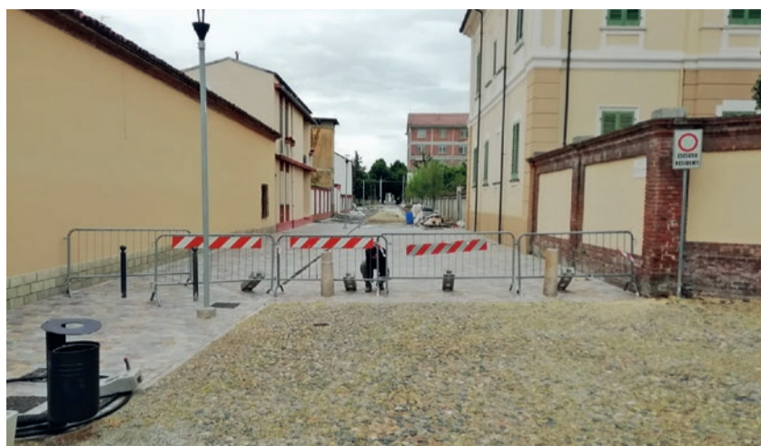
L'avanzamento dei lavori di viale Riccardo Preve
