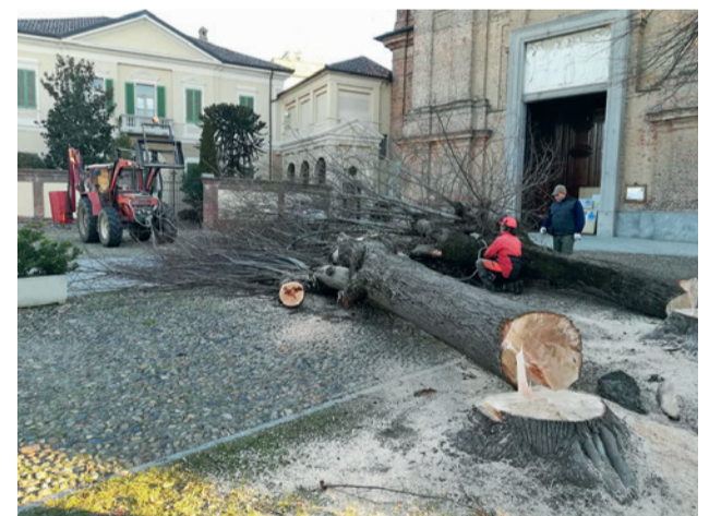
La rimozione delle piante dal sagrato della chiesa
