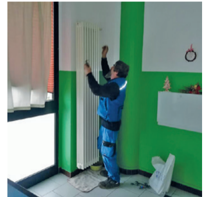
L'installazione di valvole termostatiche alla scuola media
