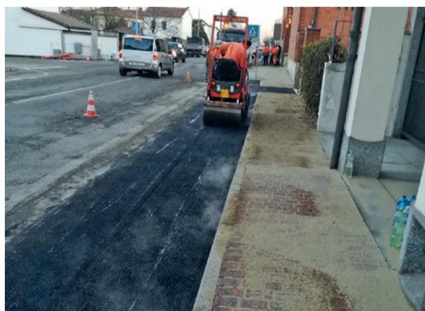
Il rifacimento delle banchine per i pedoni in via Mortara
