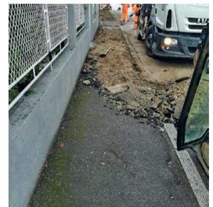
L'intervento di rifacimento del marciapiede di via San Rocco
