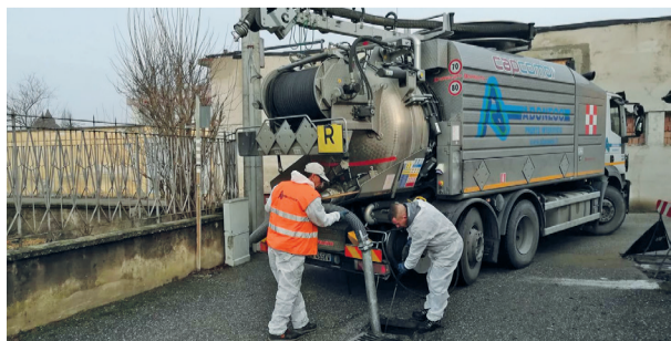
L'intervento di pulizia in un traversa di via San Rocco
