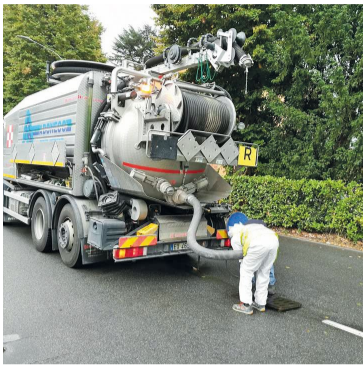
I lavori di pulizia delle caditoie
