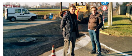
Il geometra Secondo Borando (a sinistra) e l'assessore Gregorio Rossini controllano i lavori di riasfaltatura
